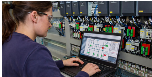
AUTOMATIZACIÓN Y CONTROL.
